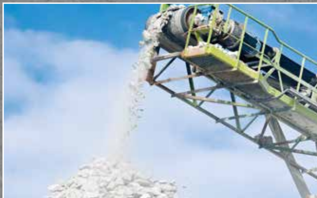
Betonrecycling, Wiederverwendung z. B. im Straßenbau.
