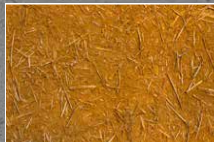
Mit Pflanzenfasern bewehrte Lehmwand.
